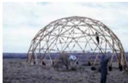
شکل 12. گنبد ژئودزیک فولر (Tucker, 1994)
